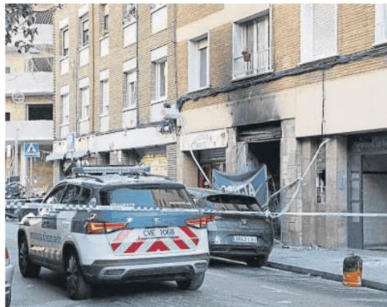
Los bajos incendiados, en el número 5 de la calle Mestre Carbó
